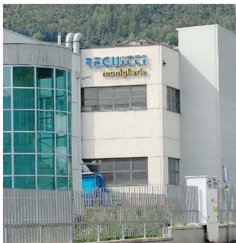
La sede. Il quartier generale Reguitti a Agnosine
